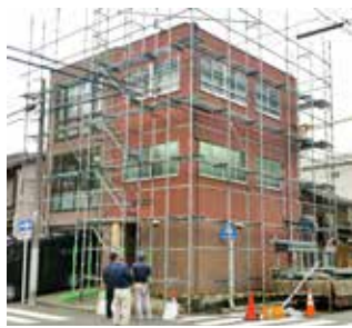
組合では10月3日より予てから取組みされていた会館の改修工事を足場掛けから着手した。工事の規模については総務委員会での議案し、谷倉委員長下で決定された。
