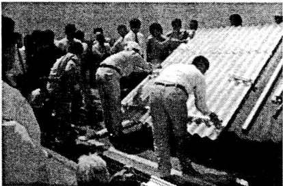
▲スレート葺き替え実習
